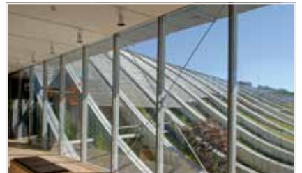
GUTMANN GCW 060 Kundenlösung Customised Construction
